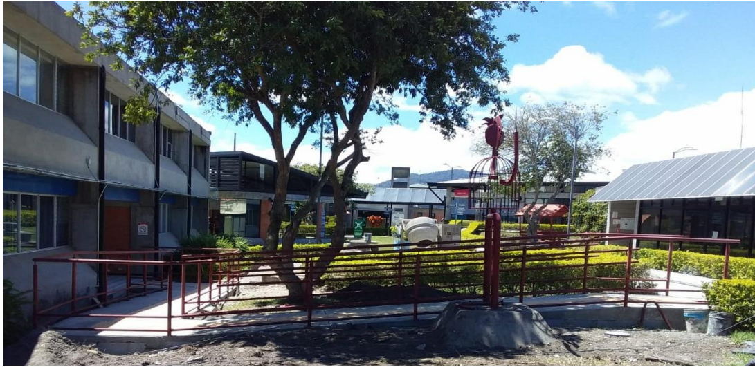
Fotografía 4: Rampa costado norte del Edificio de aulas
