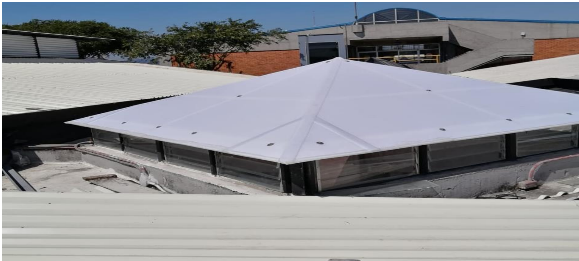
Fotografía 9: Techo costado sur y monitor Sala Marco Aurelio Aguilar
