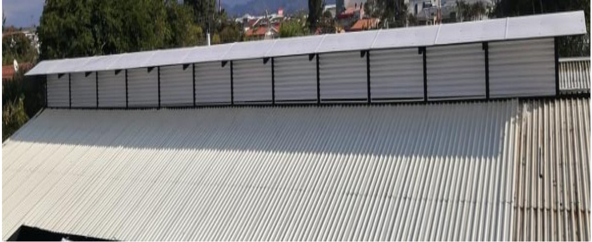
Fotografía 10: Monitor costado sur Edificio Administrativo y cambio de techo
