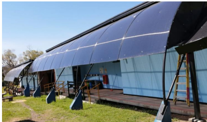
Fotografía 2: Láminas edificio aulas 19-21 y laboratorios de cómputo
