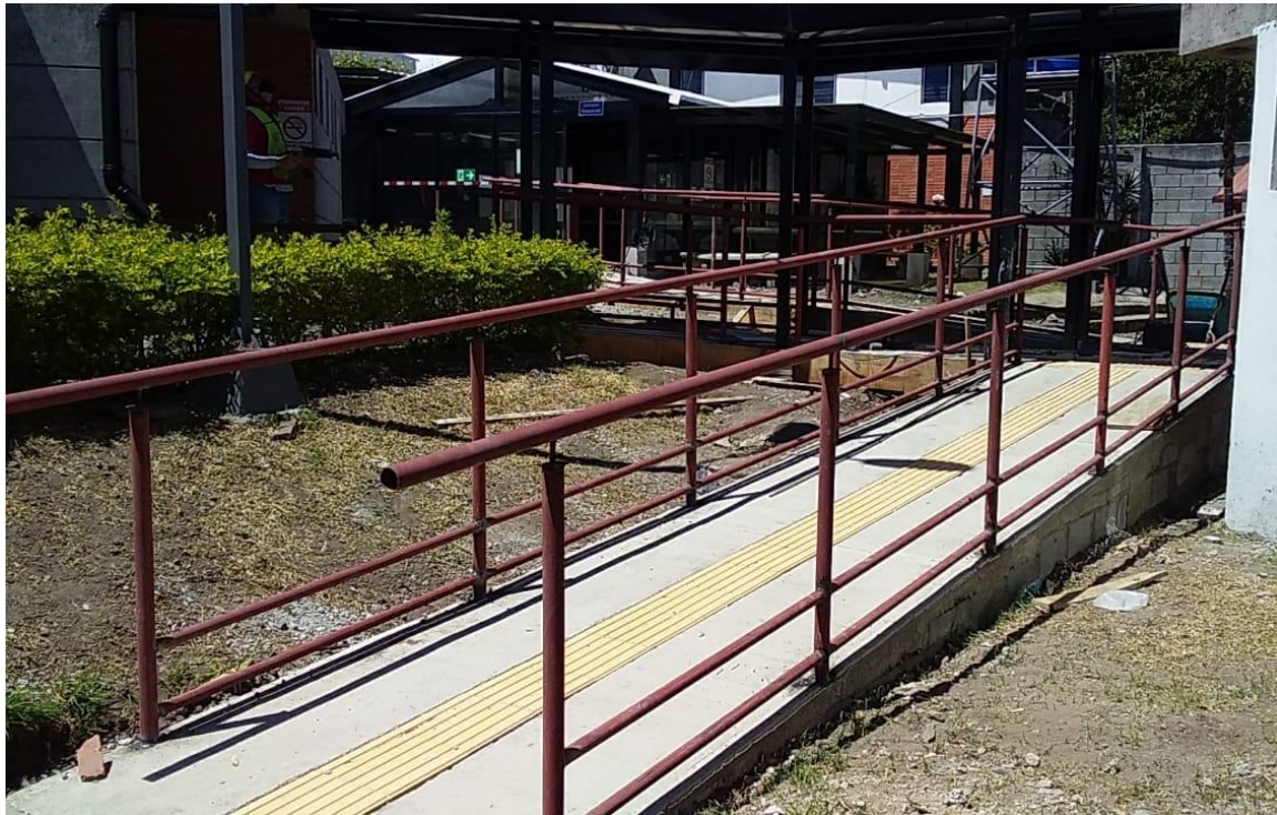
Fotografía 5: Rampa Biblioteca soda-comedor estudiantil
