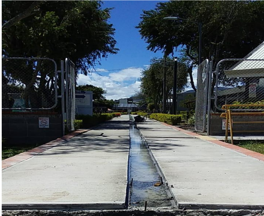
Fotografía 6: Acera interna principal
