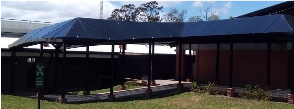
Fotografía 1: Paso cubierto Dirección Académica y edificio aulas DECAT
